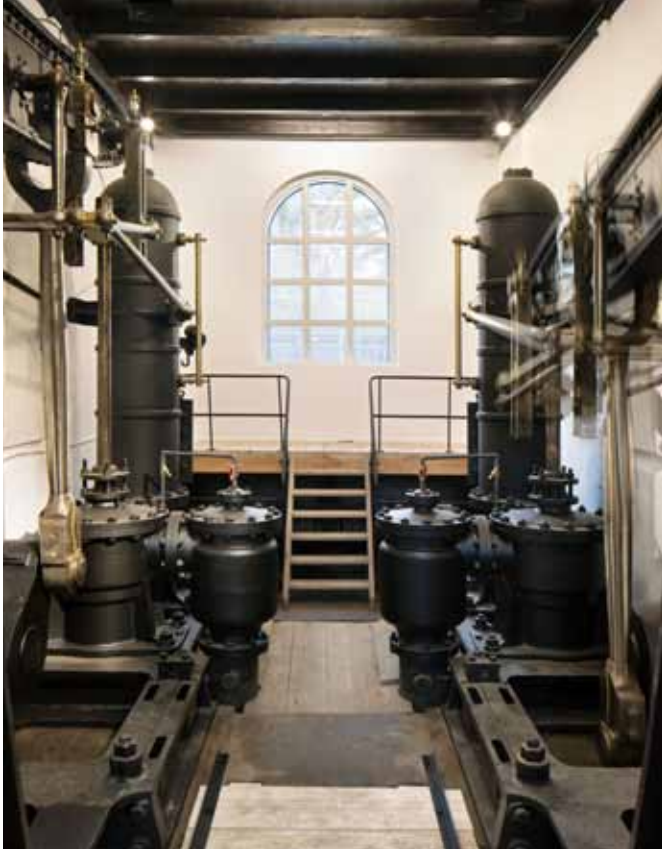
Auch die Pumpenanlage ist frisch saniert.
